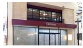
デイサービスセンター 弁天通り
